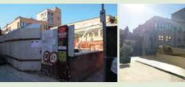
Il progetto prevede il rifacimento della pavimentazione della piazza, la costruzione di aiuole verdi e la realizzazione di arredo urbano mediante la costruzione delle sedute, lampioni, fontana, dissuasori. Il rifacimento del rivestimento della scala dell'autorimessa e la costruzione della nuova rampa. Conclude l'intervento il rifacimento della scala della piazza ed il raccordo della nuova pavimentazione
